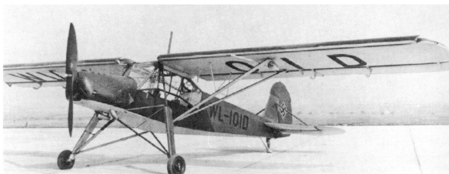
Drei Bilder von der Fi 156 B-0, W.Nr. 617, D- bzw. WL-IOID. Sie war zunächst das Musterflugzeug für die Serienausführung C-1 (Bild oben) und wurde dann nach dem Mustereinbau der Abwehrbewaffnung (SO 2) auch zum Musterflugzeug für die nachfolgende Serie C-2.
