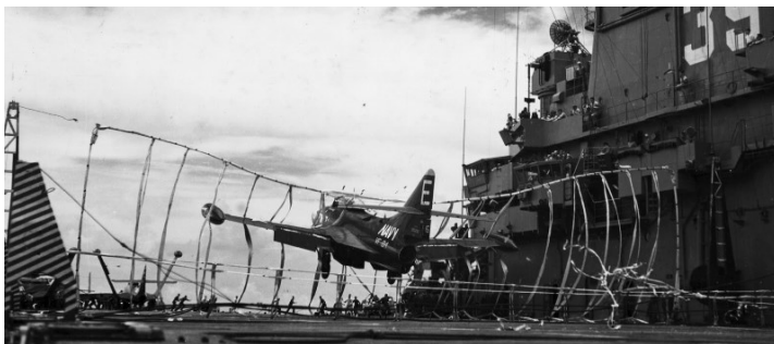
F9F in Flugzeugnotfanganlage (barricade) auf der USS Lake Champlain (CV-39)
